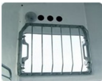
Rejas de protección en las ventanas
